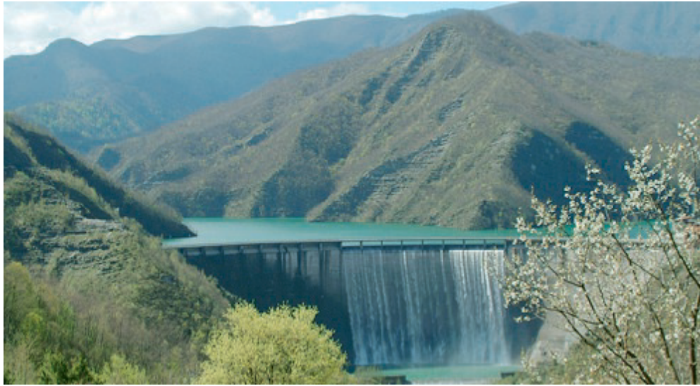
DIGA Il serbatoio di Ridracoli, sull'Appennino romagnolo in provincia di Forlì Cesena. L'opera è del tutto simile (anche come conformazione del territorio circostante) a quella che potrebbe essere costruita in Val Baganza nei pressi della Stretta di Armorano.
